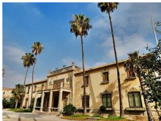
Casa-Palacio Marqués de Fontalba. Jacarilla
